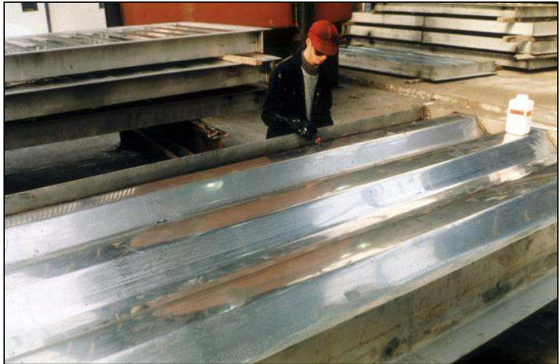
Uma parede trapezoidal resistente a explosões sendo fabricada para a parte superior de uma plataforma marítima
