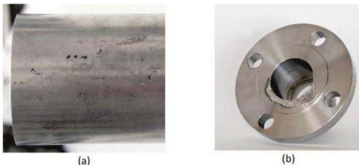
Figura 2: Corrosão por Pites em um tubo (a) e Corrosão por Frestas em uma flange (b)
